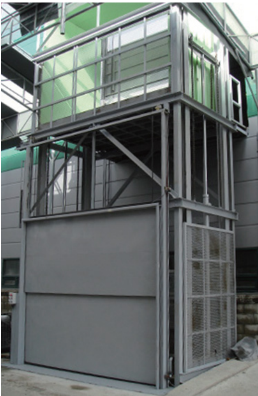
▲ 공장 내부설치 모습
